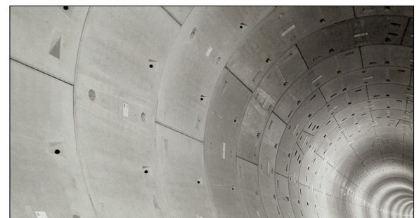
Ausbruchsicherung mit Tübbingringen https://www.rekers-beton.de
