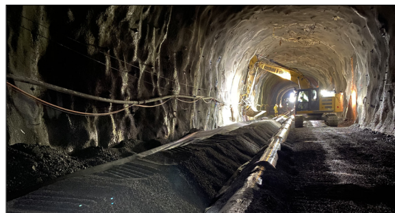
Abbildung 1 Werkleitungsbau: Hinterfüllen der Fernwärmeleitungen Eigene Darstellung
